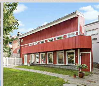
Rehabilitering av boliger
